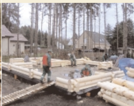
Balk voor balk wordt het huis opgebouwd.
